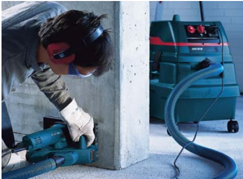
Abb. 14 Mauernutfräse mit Staubabsaugung
