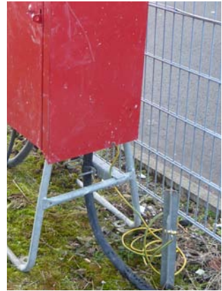
Abb. 4 Beispiel für eine fachgerechte und zuverlässige Ausführung der Erdung
