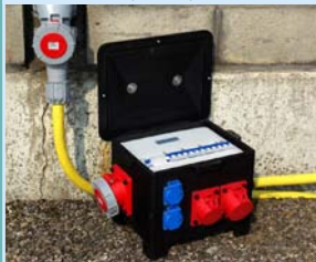
Stromverteiler mit Steckdosen (mobil)
