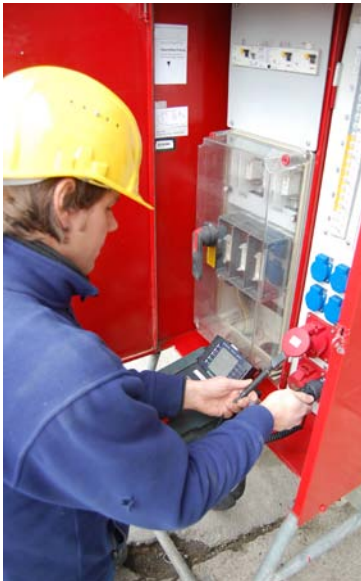
Abb. 10 Inbetriebnahmeprüfung eines Baustromverteilers nach VDE 0100-600
