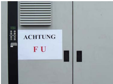
Abb. 6 Beispiel für die Kennzeichnung eines frequenzgesteuerten Krans, hier Anschlusschrank mit Frequenzumrichter (FU)
