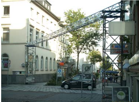
Abb. 1 Hochgelegte Leitung zur Straßenquerung
