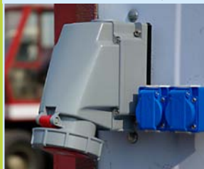
Steckdosen (unbekannte Schutzmaßnahme)
