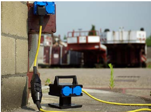
Abb. 13 Schutzverteiler mit vier Steckdosen
