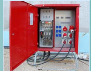
Baustromverteilerschrank
