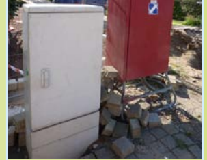
Kabelverteilerschrank
