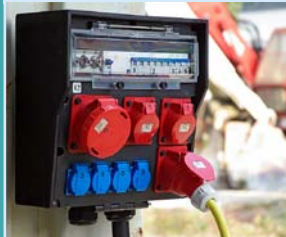
Stromverteiler mit Steckdosen (stationär)
