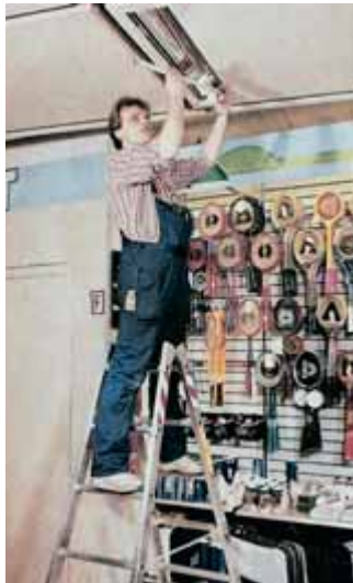
Bild 44: Sicherer Stand bei Über-Kopf-Arbeiten
