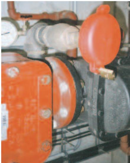
*Bild 8-4: Sicherung von Ventilen gegen unbefugtes Öffnen, Beispiel 2*
