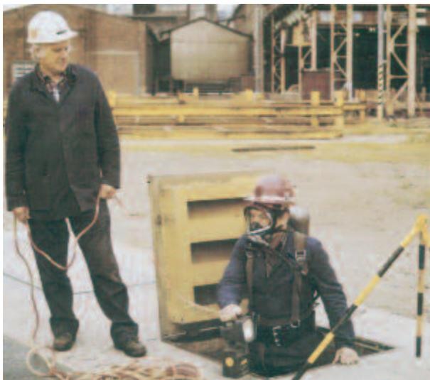
*Bild 8-5: Einstieg in einen engen Raum mit den erforderlichen persönlichen Schutzausrüstungen und Sicherung durch eine Person*
