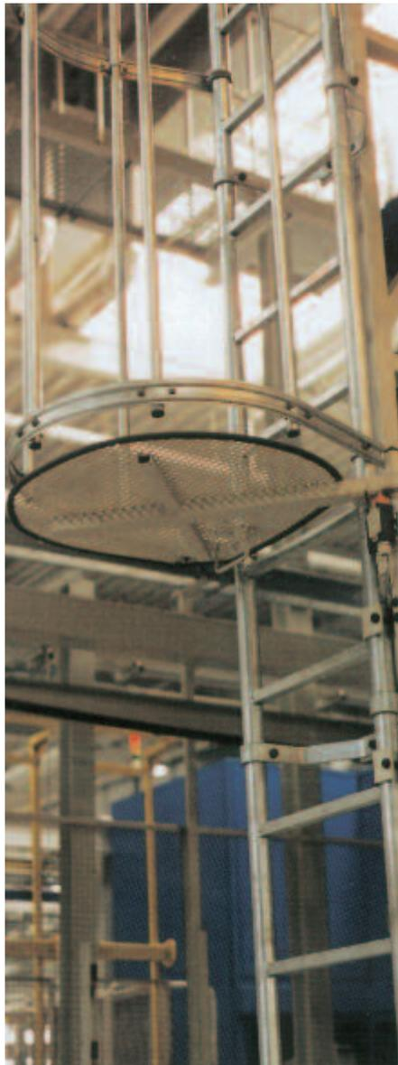
Bild 2-3: Nachträgliche Ausrüstung einer Steigleiter mit rutschhemmenden Sprossen
