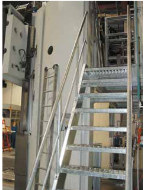
Bild 2-54: Treppe zur Schaltschrankbühne eines großen Bearbeitungszentrums
