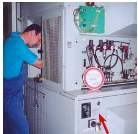
Bild 2-57: Sichere Störungsbeseitigung; Absicherung mittels Vorhängeschloss
