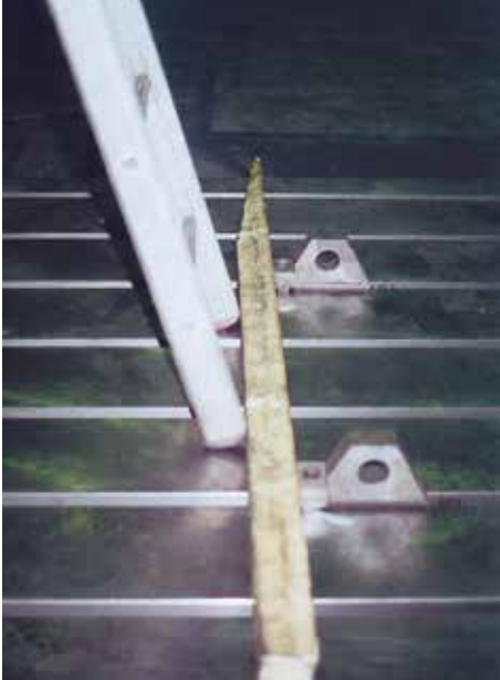
Bild 2-7: Ungeeignete Sicherung einer Leiter gegen Wegrutschen
