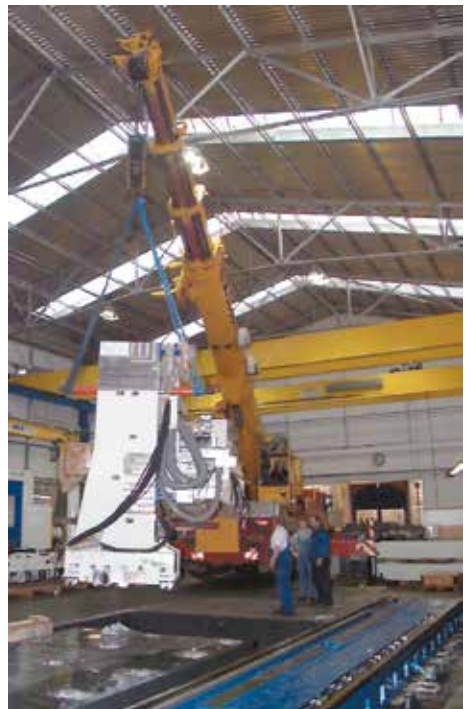
Bild 2-9: Maschine im Autokran
