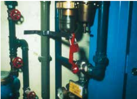
Bild 2-19: Abschließbarer Hauptschalter für die Pneumatik
