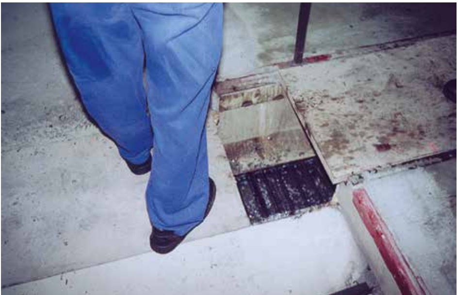
Bild 2-58: Unvollständig abgedeckter Späneförderer
