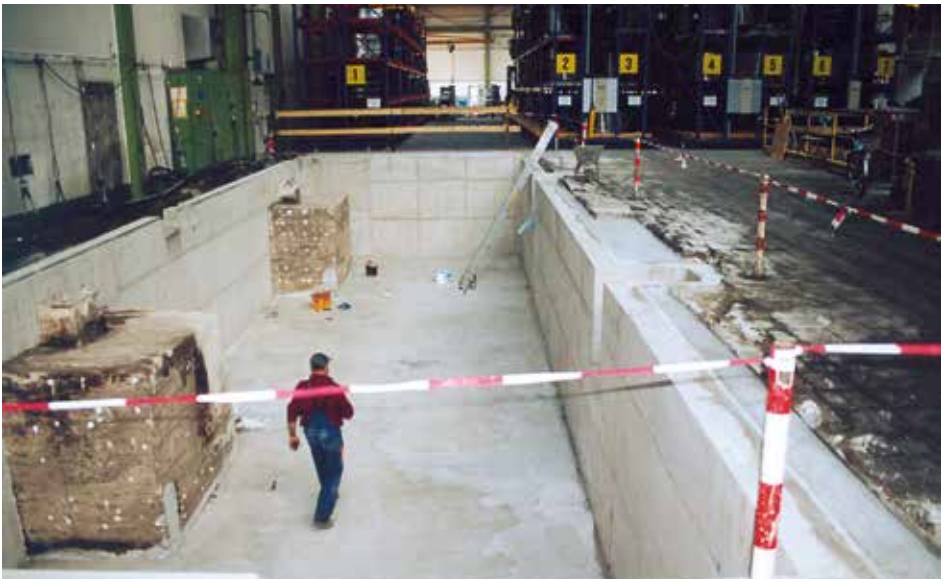
Bild 2-11: Unzulässige Maßnahme gegen Absturz (Flutterband) an der Fundamentgrubenkante
