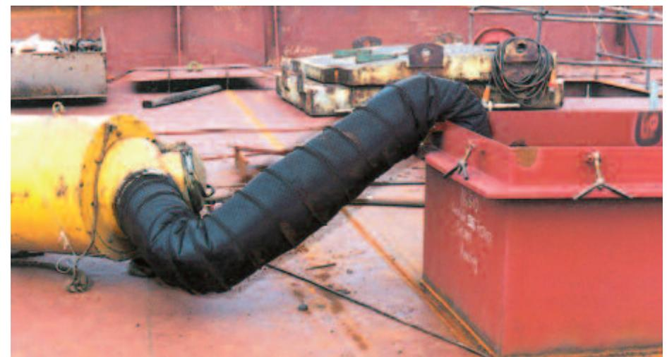
Durch entsprechende Luftführung ist dafür zu sorgen, dass die beabsichtigte Maßnahme nicht durch „Kurzschlusslüftung“ zunichte gemacht wird.
