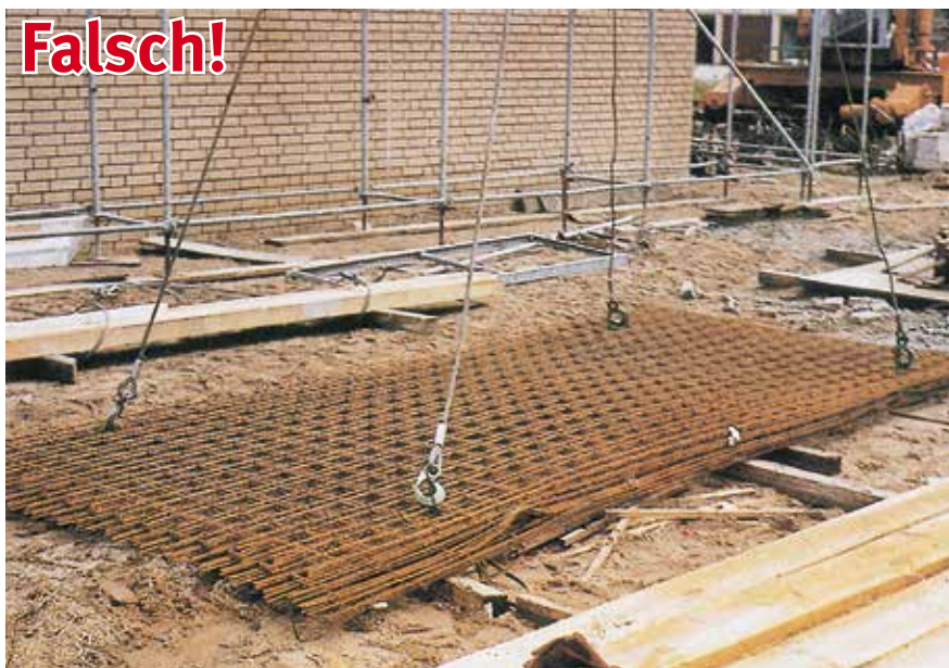
Bild 16-5: Einhängen in die Umschnürung ist lebensgefährlich!
