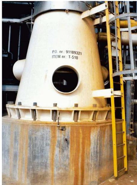
Abb. 8 Schuss unter einer Kolonne
