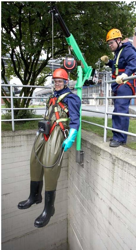
Abb. 25 Zugangsverfahren mittels Auffanggurt und Rettungswinde
